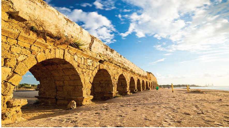
Aqueduto de Cesareia Maritima, em Israel, construído cerca de 20 anos antes de Cristo.
