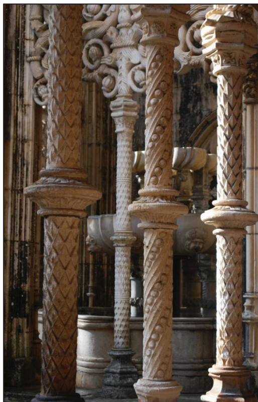
Colunas do Mosteiro da Batalha.
